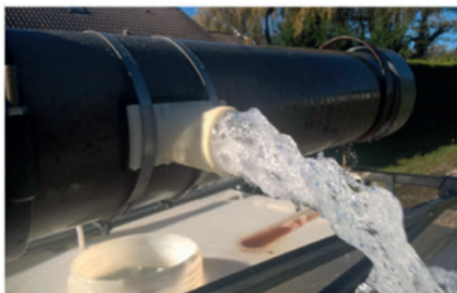
Tuyau à vannes et les buses calibrées en détail
