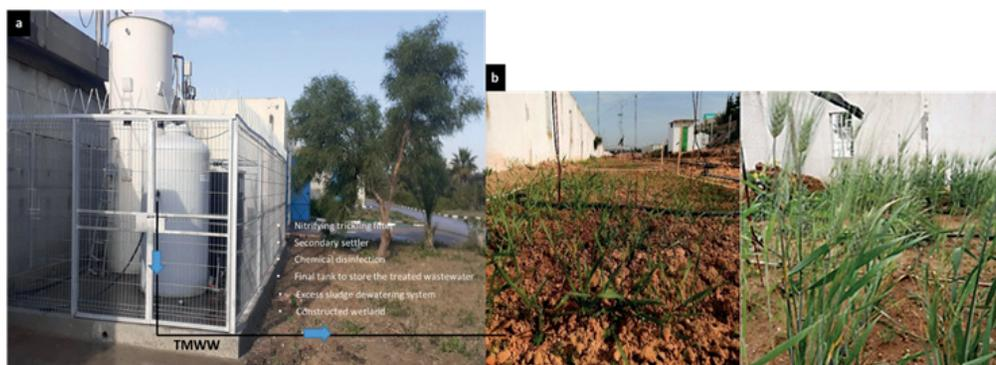
Figure 2- a) Processus de traitement des eaux usées municipales dans la station d'épuration de Chotrana (Ariana, Tunisie), b) Blé irrigué avec des eaux usées municipales traitées à l'aide de micro-asperseurs
