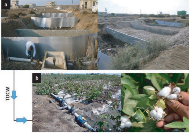
الشكل 5- (أ) عملية معالجة مياه قنوات الصرف الزراعي في بحيرة المنزل في مصر، (ب) نباتات القطن المروية بمياه قنوات الصرف المعالجة باستخدام الأنابيب المزودة بفتحات معيارية
