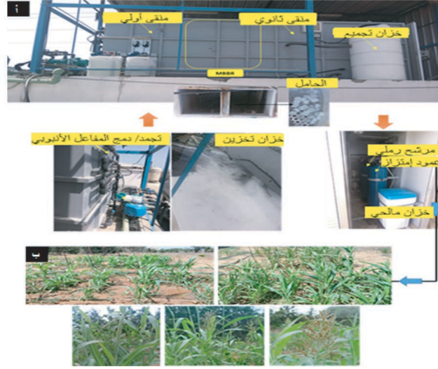
الشكل 4 (أ) - عملية معالجة مياه صرف المنسوجات في صناعة النسيج بتقنية GWash (نابل - تونس)، (ب) سنايل الذرة البيضاء في مراحل نمو مختلفة مربية بمياه الصرف المعالجة باستخدام رشاشات دقيقة
