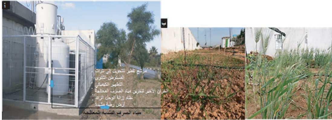
الشكل 2- أ) عملية معالجة مياه الصرف البلدية في محطة معالجة مياه الصرف في شطراثة (أريانة - تونس)، ب) القمح المروي بمياه الصرف البلدية المعالجة باستخدام الرشاشات الصغيرة
