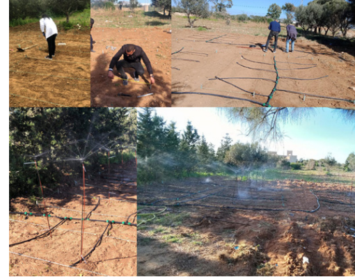
المحطة التجريبية الثانية لمعالجة مياه الصرف الناتجة عن صناعة المنسوجات في نابل - تونس: تركيب شبكة الري في الحقول التجريبية
