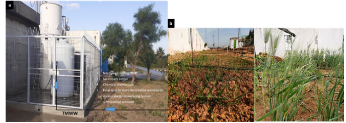
المحطة التجريبية الأولى في محطة سُطْرانة لمعالجة مياه الصرف البلدية في أريانة - تونس: (أ) صورة المحطة التجريبية؛ (ب) القمح المروي بمياه الصرف البلدية المعالجة باستخدام الرشاشات الصغيرة
